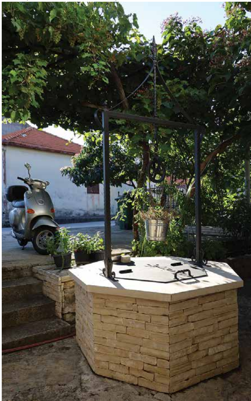
Obnovljeni bunar u dvorištu Tonija Jelenkovića (Buškala)
