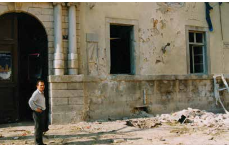
Ivan Pehar ispred Gradske knjižnice Zadar 5. listopada 1991. (fotografija Arifa Ključanina)
